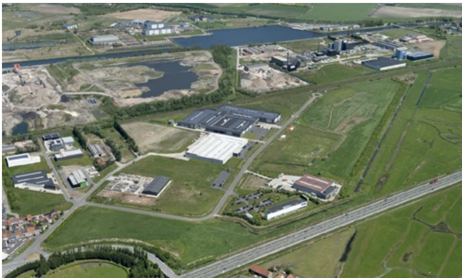
Het bedrijventerrein van Oostende, waar Smart Energy Link getest wordt. © WWI
